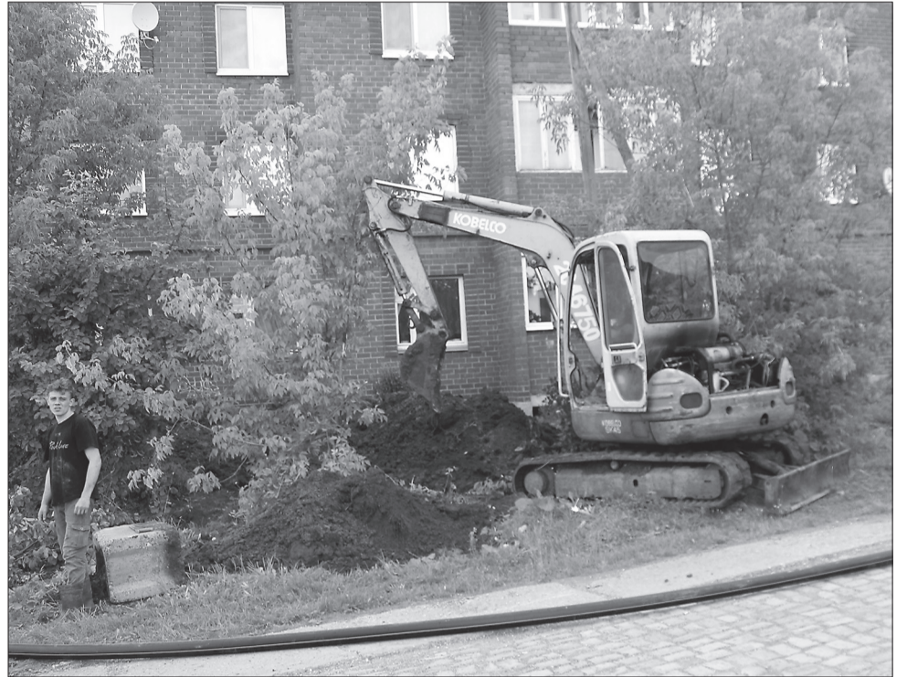
Менять ветхие водопроводные сети в с.Уинское начали с улицы Ленина
