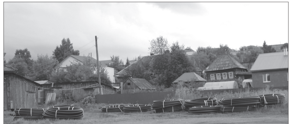
Всего планируется заменить 1730 метров старых водопроводных сетей. Материалы завезены
