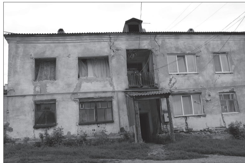
В будущем году этот аварийный дом снесут...
