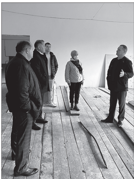
Ход ремонта ДК в д.Иштеряки контролировали и глава округа Алексей Зеленкин, и депутат ЗС.Александр Козюков. А совсем скоро его результат смогут оценить и все жители д.Иштеряки
