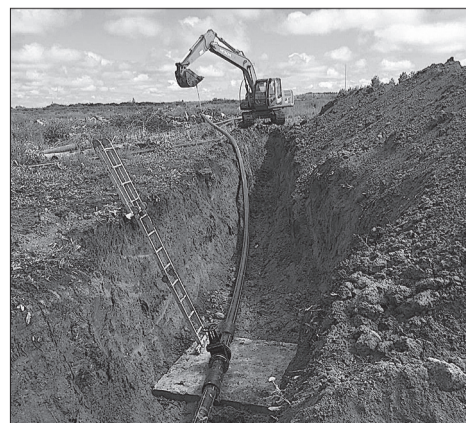
Работы по реконструкции системы водоснабжения, с. Суда
