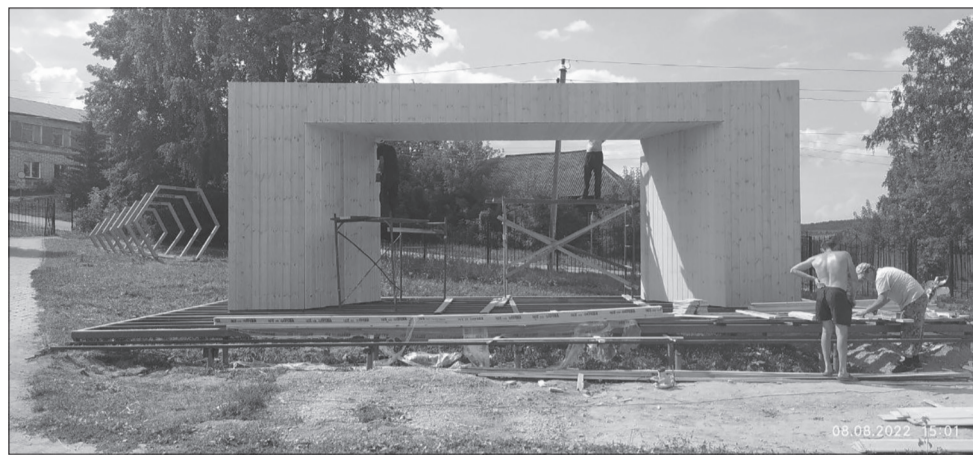
В рамках реализации второго этапа благоустройства историко природного комплекса «Уинский парк» ведутся работы по установке сцены. Качество работ артисты смогут оценить уже в Медовый Спас.
