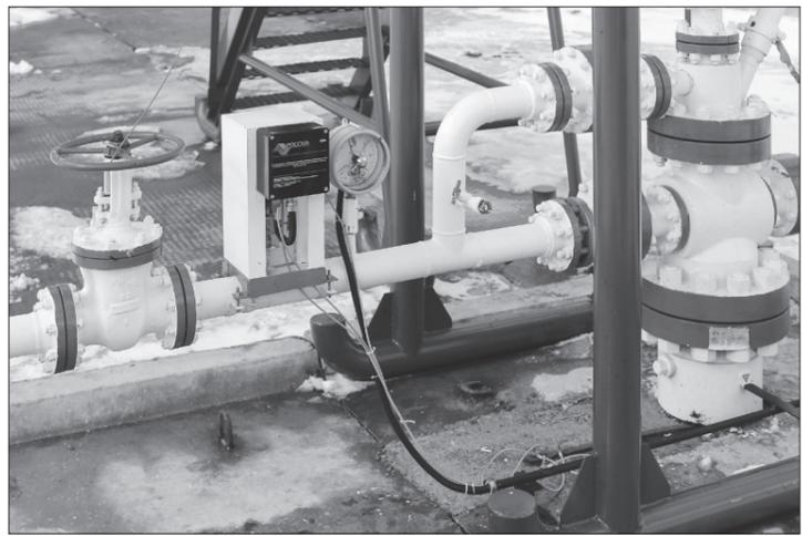
Измерительными коммутаторами оборудованы 43 из 67 скважин Аспинского месторождения. «Умная скважина» дает нефтяникам возможность онлайн-контроля технологического оборудования, а также удаленного управления скважиной
